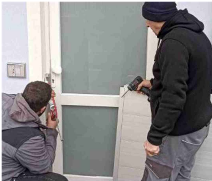
Il montaggio di una paratia per impedire all'acqua di entrare nell'abitazione in caso di alluvione (foto Luca Ravaglia)
